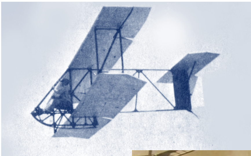
ד"ר מרטין זולטן עסק רבות בתעופה, במיוחד בטיסנים ובדאונים. למעלה: דון-דו-מושבי מקורי שתכנן ד"ר זולטן
