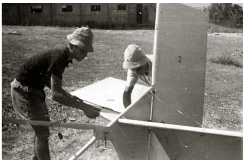
חניכים מרכיבים דאון מסוג וורונה. הדאון המקורי נבנה בפולין. לאחר מכן נבנו דאוניס מסוג זה בארץ בבית הספר 'עמל' חדרה, בשיתוף עם מועדון התעופה בחדרה
